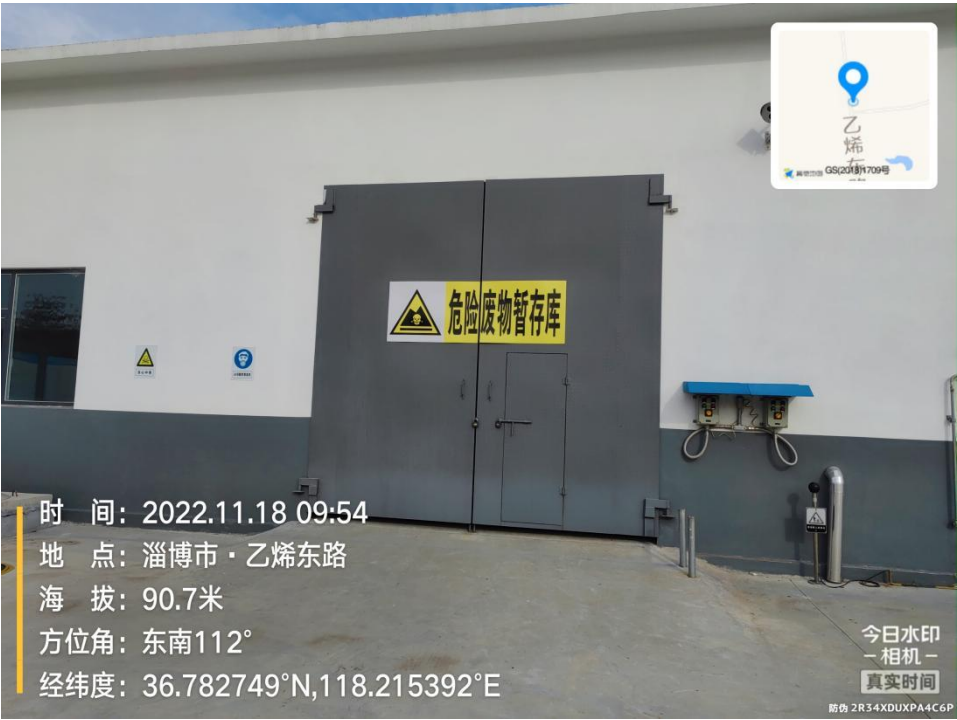
附图 5 项目现场照片
