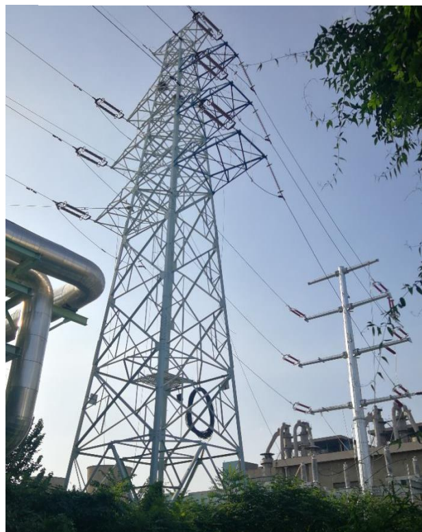
图 4-3 改造的 110kV 终端塔
