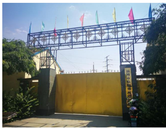
淄博市临淄鼎越建材厂（西侧正门）
