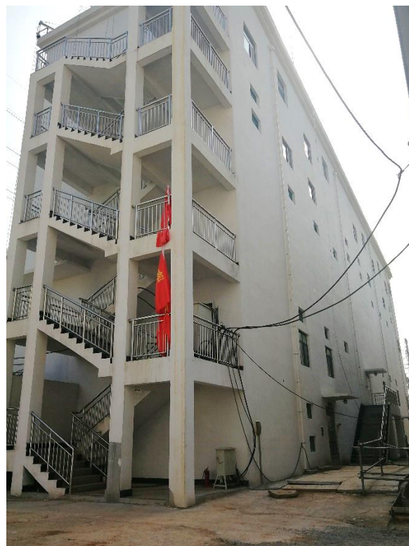
图 4-4 新建的 110kV 配电装置
