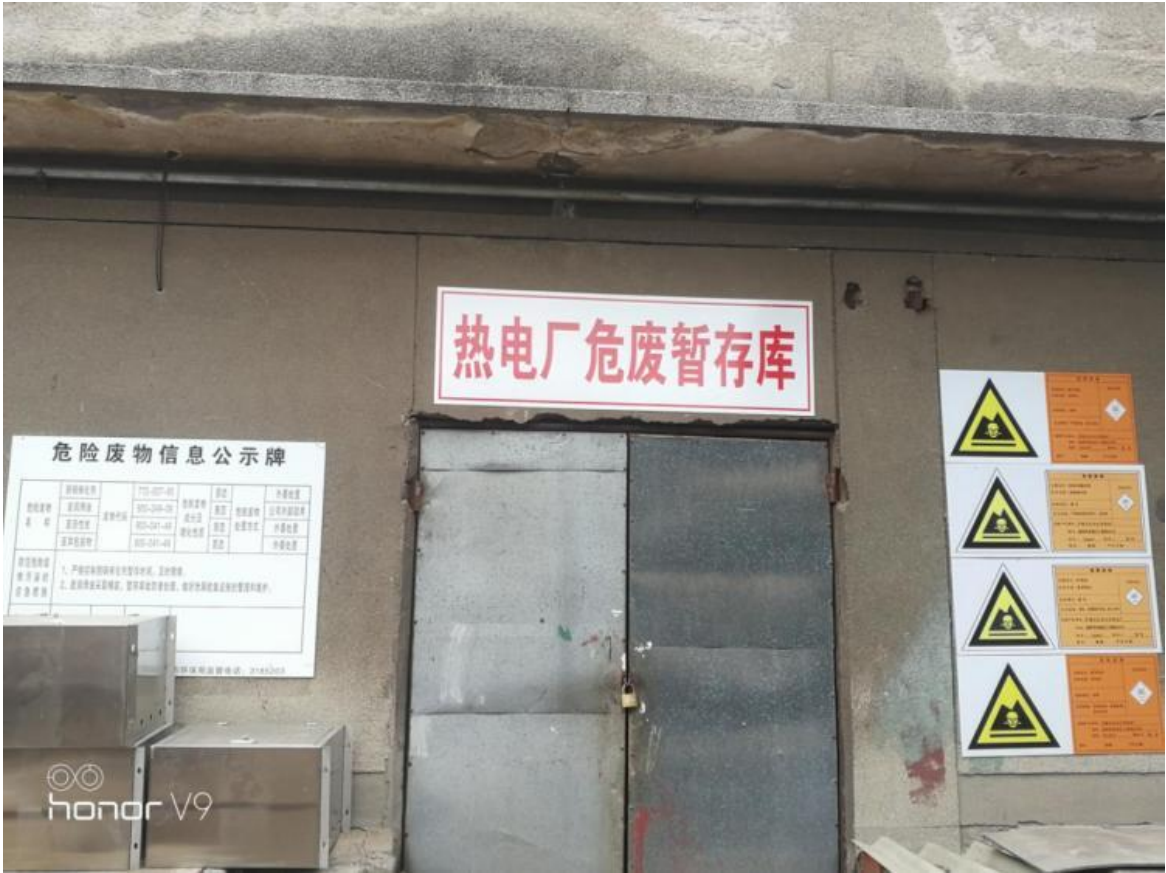
附图6：厂区现有危废暂存库
