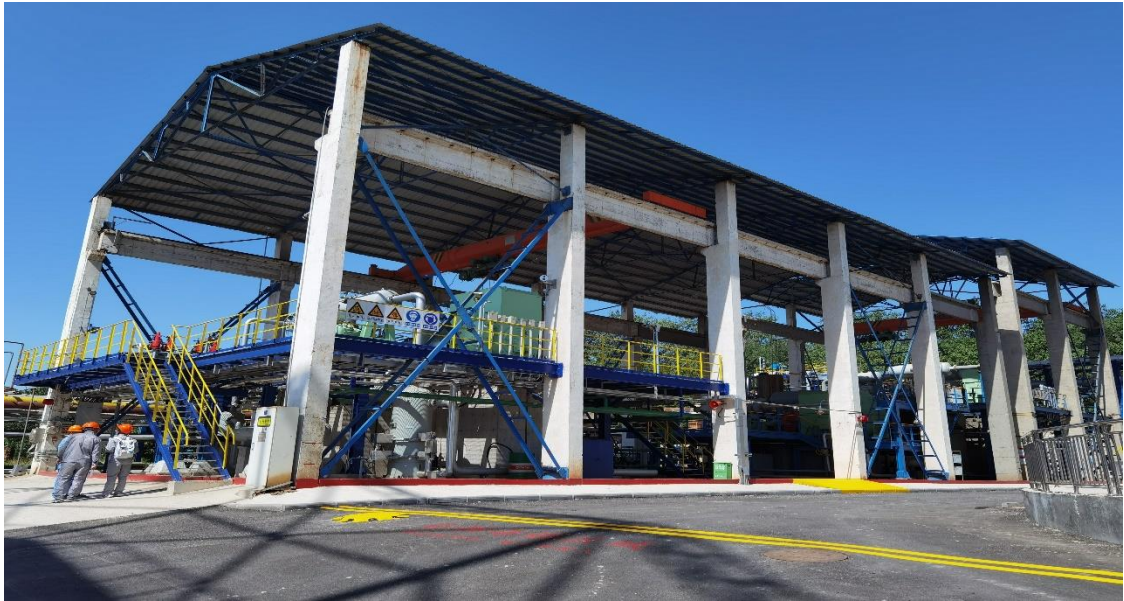
压缩机组厂房
