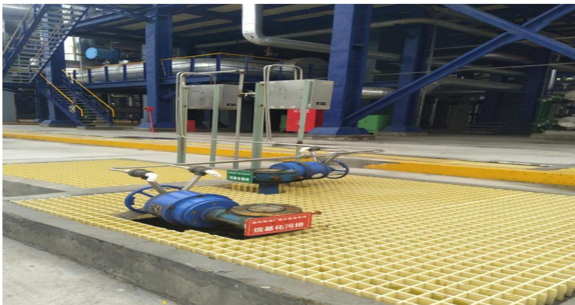
图 4.4-6 雨污切换及标识照片
