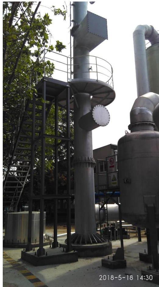
图 11-4 第二污水处理场废气处理装置
