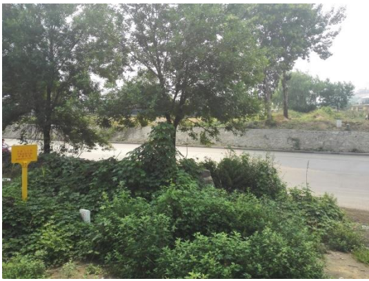
穿乙烯路管线现状
