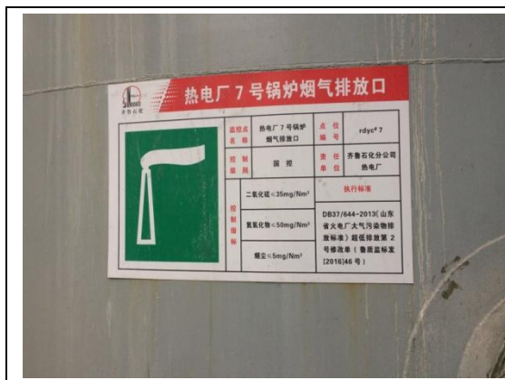
排放口标识牌
