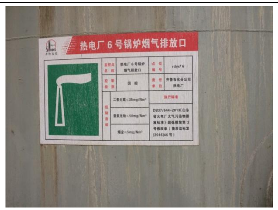
排放口标识牌
