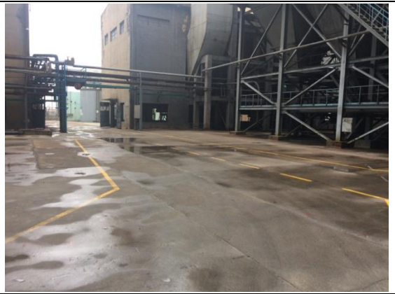
除尘区地面水泥硬化
