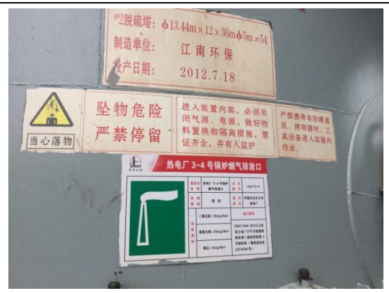
排放口标识牌
