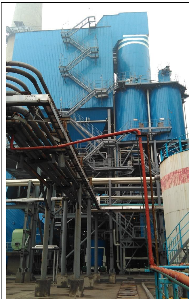
1#炉脱硫、脱销系统（北）
