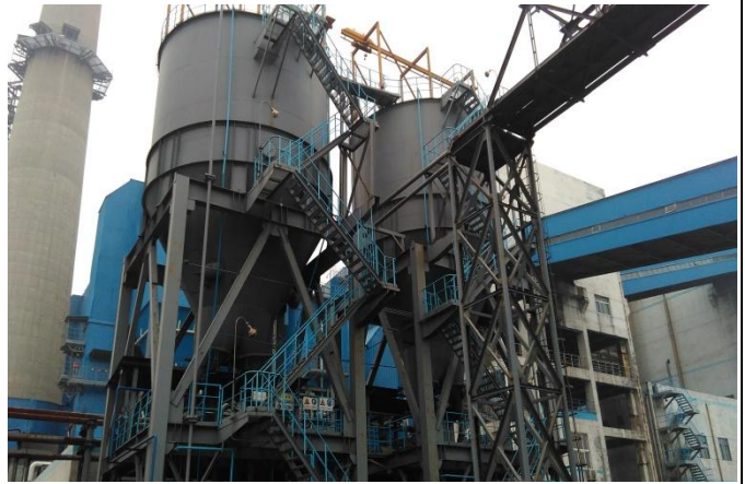
脱硫系统（石灰罐）
