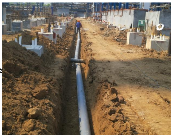
② 地下污水管道及井结构施工照片资料
