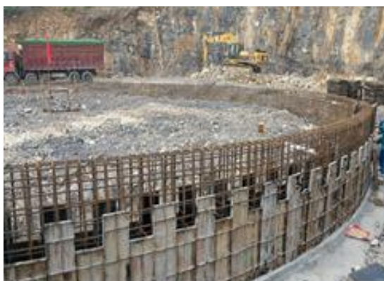
③ 新建储罐区罐基础防渗施工材料
