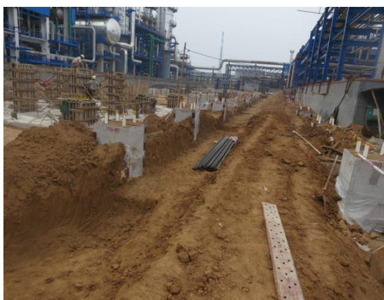
② 地下污水管道及井结构施工照片资料
