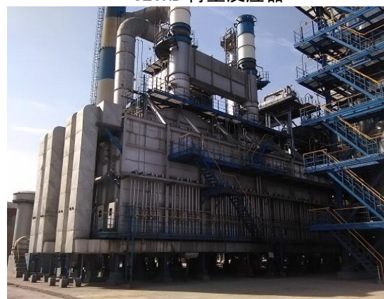
反应进料加热炉
