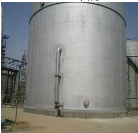
北区 5000m 3 事故罐
