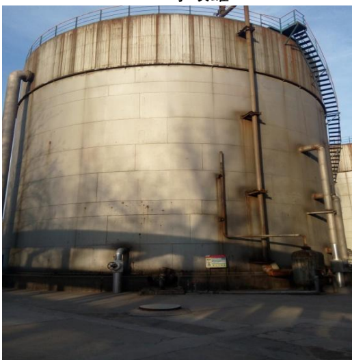
北区 5000m 3 事故罐
