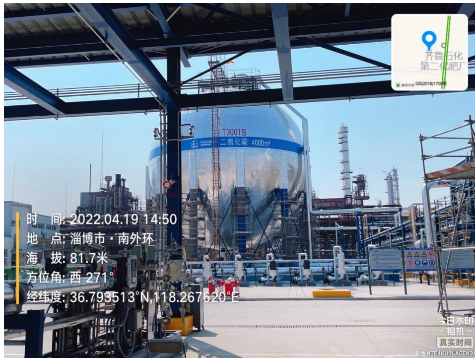
附图 3 项目现场照片
